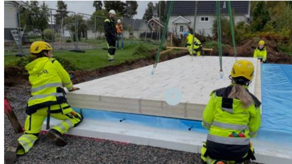
Montering av trägrundläggning, Fiskarhedenvillan Villa ZERO, 2022
